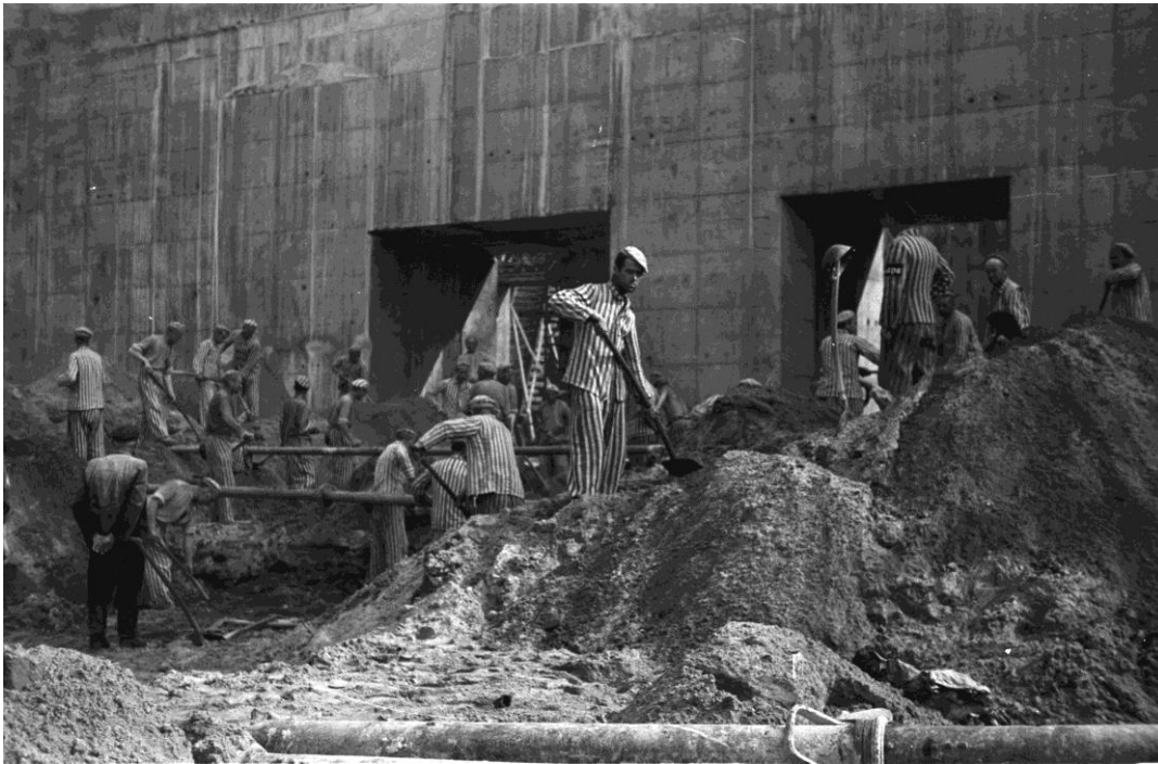
Foto im offiziellen Auftrag: Häftlinge bei der Arbeit im KZ-Außenlager Bremen-Farge, 1944 (Quelle: Bundesarchiv Koblenz, 185/10/21)
