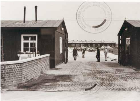
L'ingresso del Lager, veduta del piazzale lastricato dell'appello.
