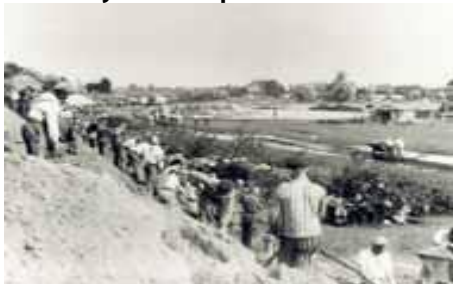
Prisioneros trabajando en los taludes del dique de Neuengamme.
